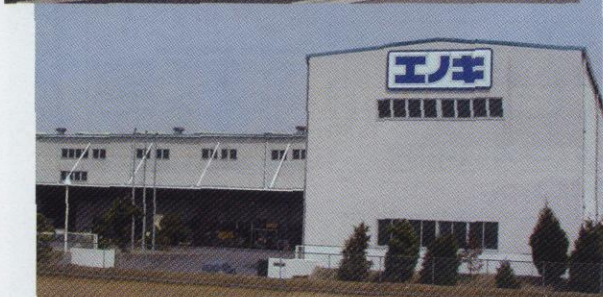
滋賀水口工場
