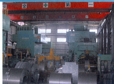
プレス工場(1500tトランスファープレス)
